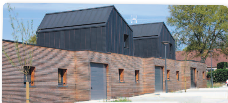
Étival-lès-Le Mans, 2013 : logements BEPOS
