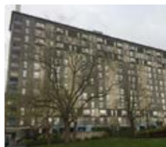
Devenu trop coûteux à rénover, la démolition de ce bâtiment de 12 étages rue E.Chabrier, chargé de souvenirs et d'histoires, devrait débuter à l'automne 2021.
