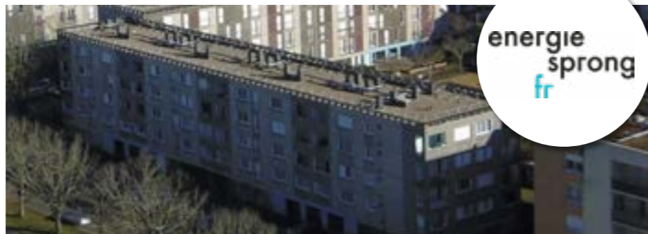
81 logements collectifs seront réhabilités à Allonnes sur le modèle EnergieSprong.
