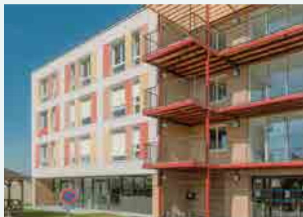
Résidence Métais à Connerré
