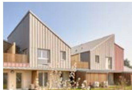
SABLÉ-SUR-SARTHE - Avenue de Montreux Maître d'œuvre : Penneron Architectes ©François Jouanneaux
